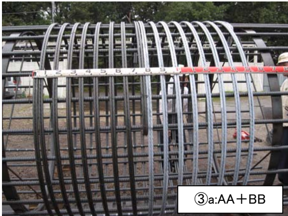
写真-1 8巻束ねフープ筋施工完了状況
