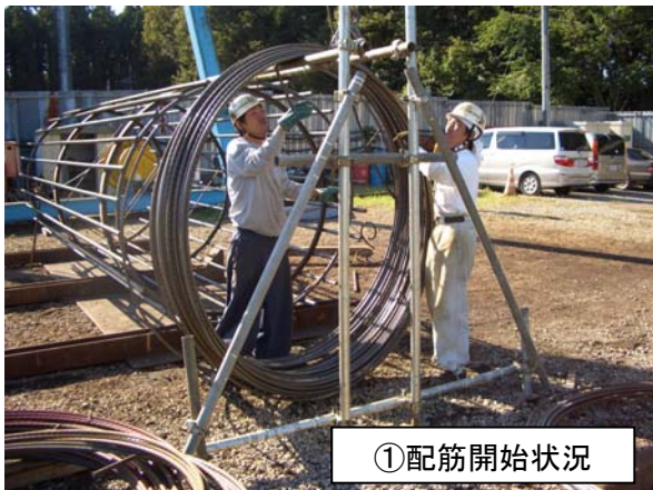
写真-2 48巻1束貫通方式施工試験状況
