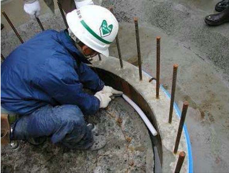
バックアップ材の取付
