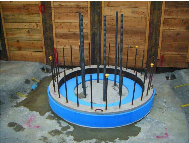
緩衝材の設置・施工完了
