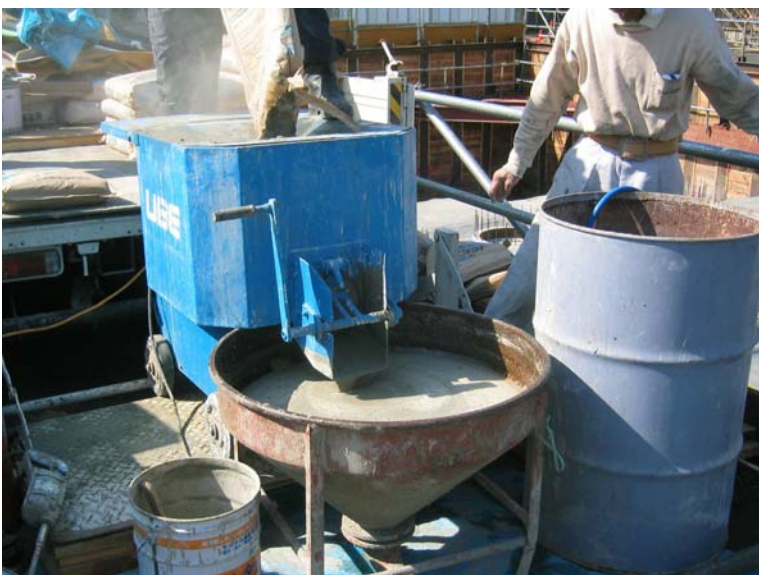
グラウト練(現場サイト)
