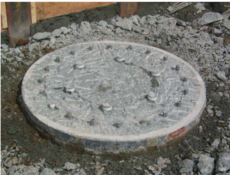
杭頭処理の完了
