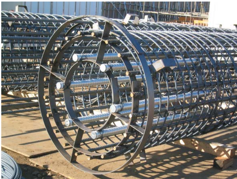
杭鉄筋組立・シース取付
