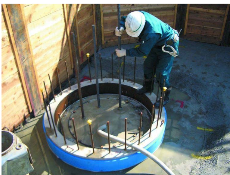
引張定着筋の挿入
