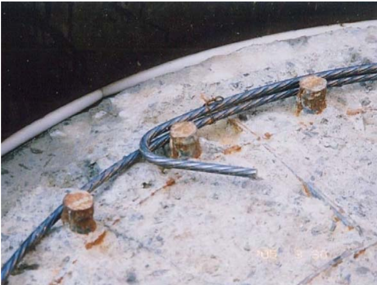
杭頭補強筋設置
