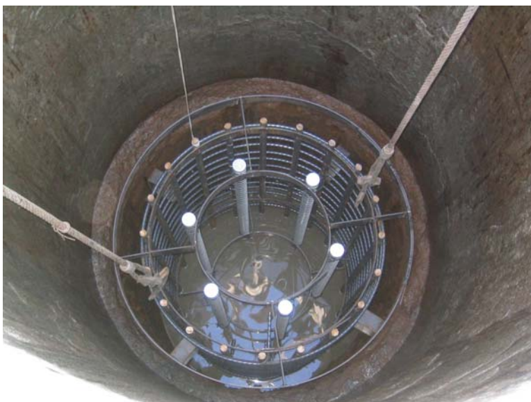
杭鉄筋建込・コンクリート打設
