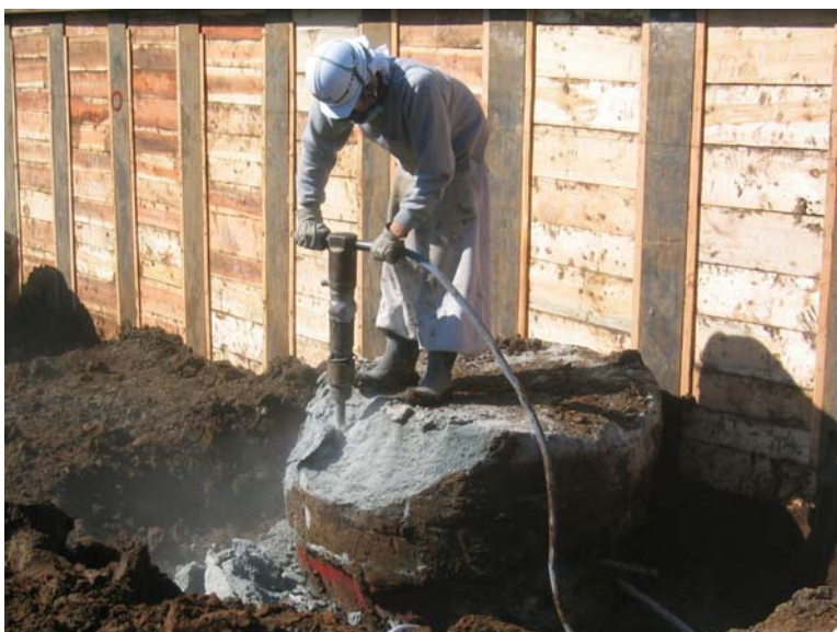
杭頭部のはつり
