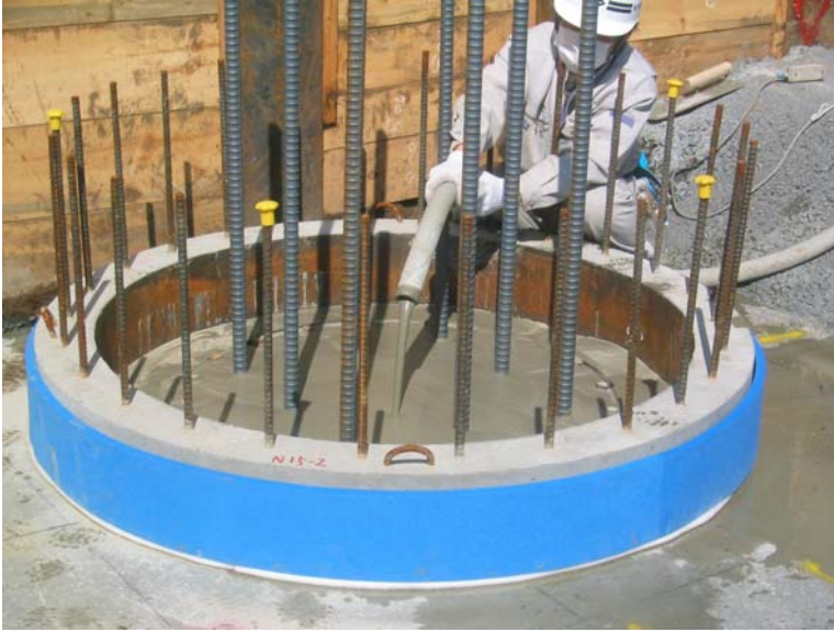
杭頭接合部モルタル打設
