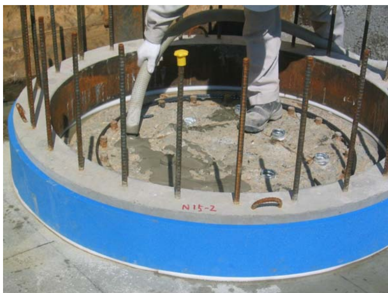
シース内グラウト打設
