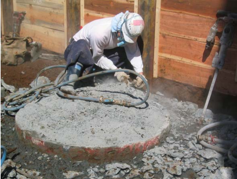
杭頭部の仕上はつり
