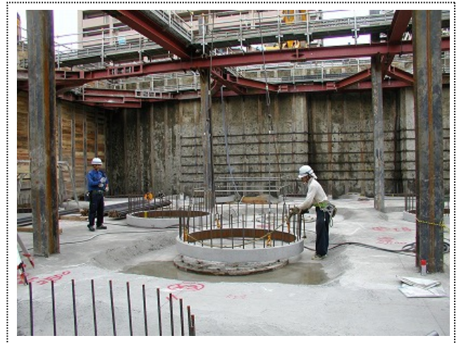
写真-5 PCリングの設置
