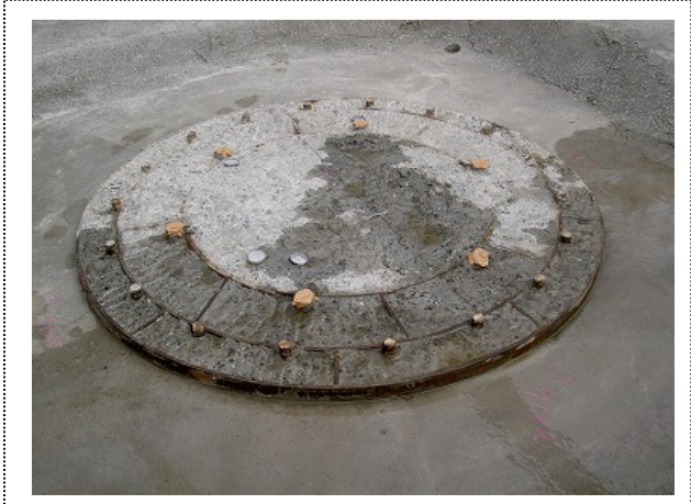
写真-3 杭頭処理後
