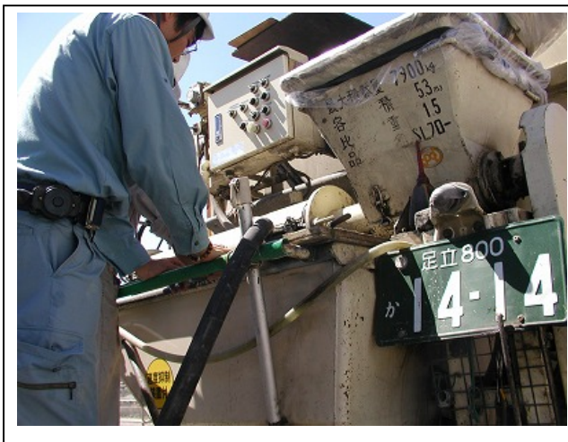
写真-8 ローリー車によるモルタル圧送
