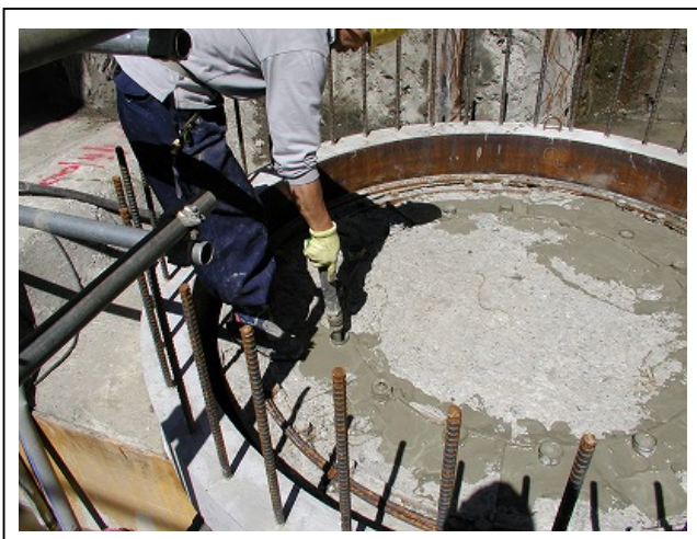
写真-9 シース内へのモルタル充填
