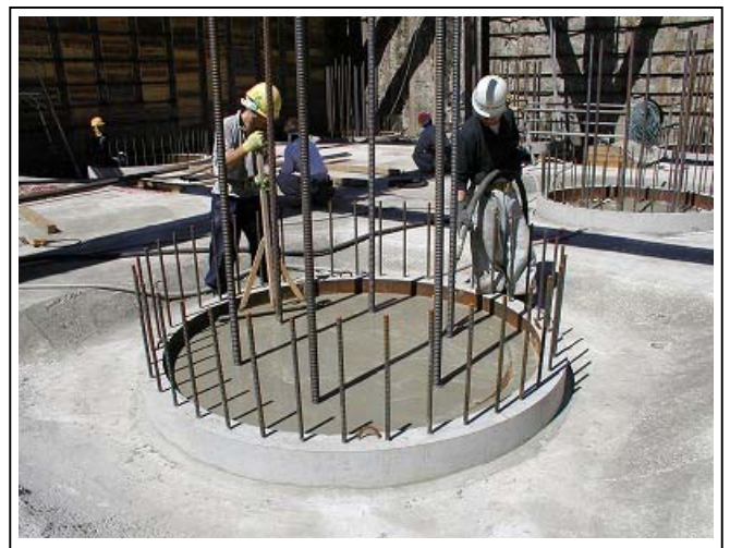
写真-11 杭頭接合部へのモルタル流し込み
