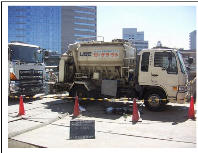
写真-7 ローリー車によるモルタル製造
