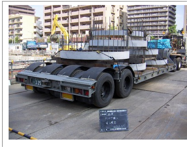
写真-4 PCリングの搬入
