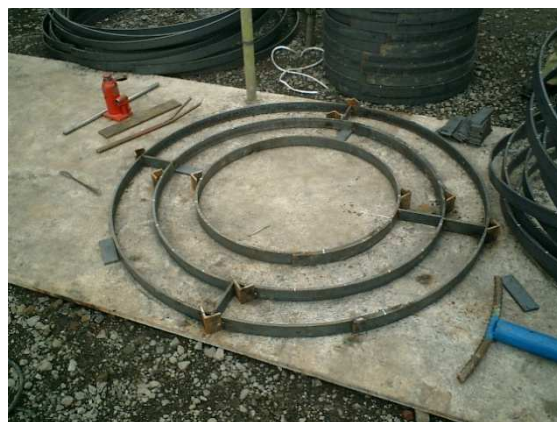
写真 1. 杭径整形ガイドリング製作
