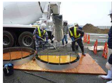
コンクリート打設状況
