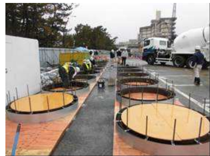
サイトPCリング ヤードセット状況
