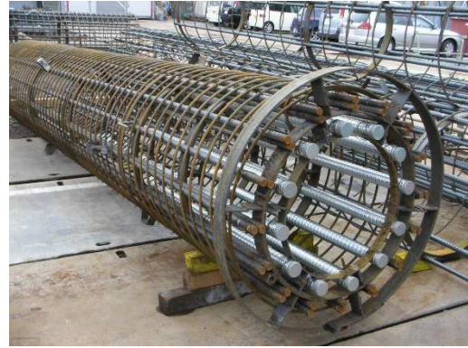
写真 3. 杭頭部組立完了
