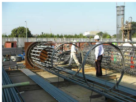
写真 2. 主筋取付け
