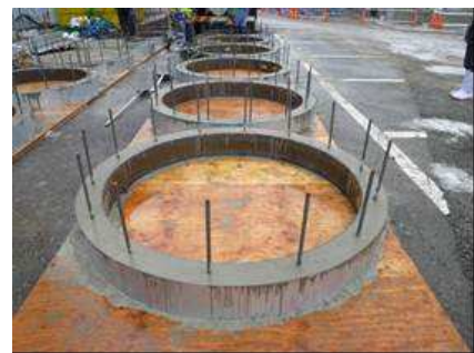
コンクリート打設後
