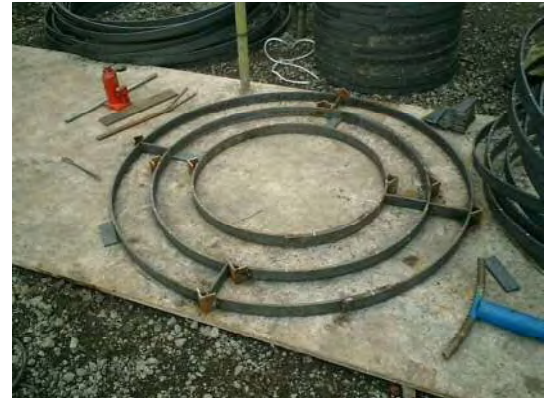
写真 1. 杭径整形ガイドリング製作
