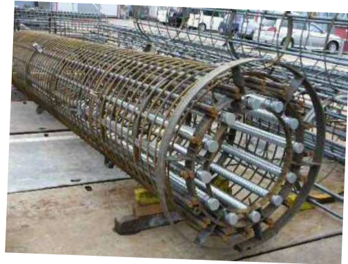
写真 3. 杭頭部組立完了
