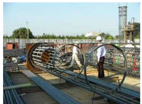
写真 2. 主筋取付け
