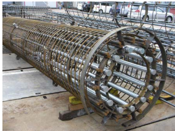
写真 3. 杭頭部組立完了
