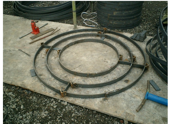
写真 1. 杭径整形ガイドリング製作
