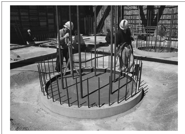
写真—11 杭頭接合部へのモルタル流込み
