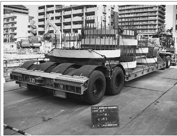
写真—4 PCリングの搬入
