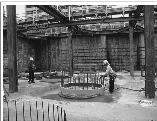
写真—5 PCリングの設置
