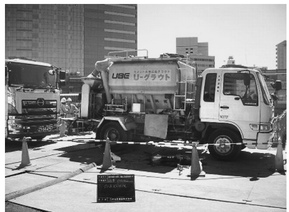
写真—7 ロリー車によるモルタル製造
