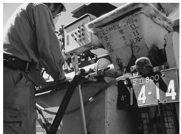
写真—8 ロリー車によるモルタル圧送
