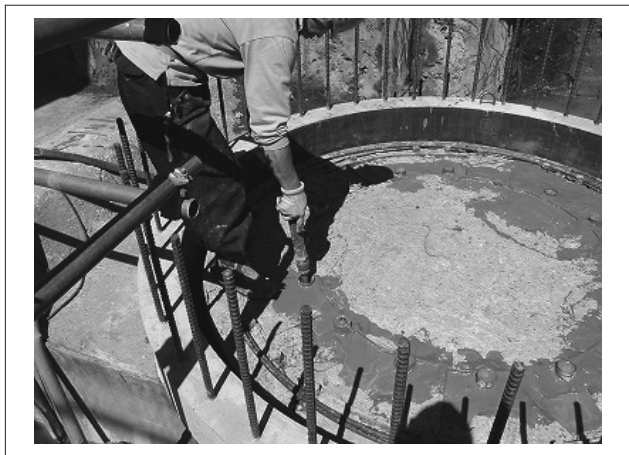
写真—9 シース内へのモルタル充填
