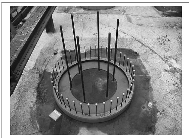
写真—12 杭頭部への発泡ポリエチレン設置
