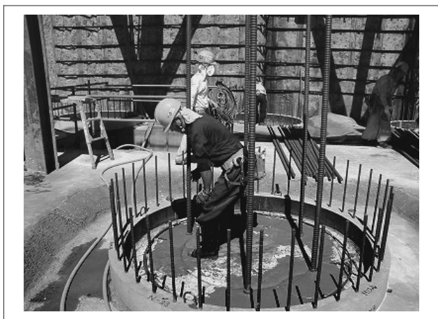
写真—10 引張り定着筋の挿入
