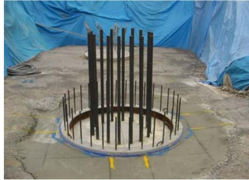
写真1. 2回目捨てコンクリート完了
