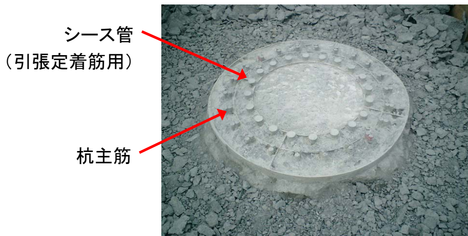
＜杭頭処理状況＞
