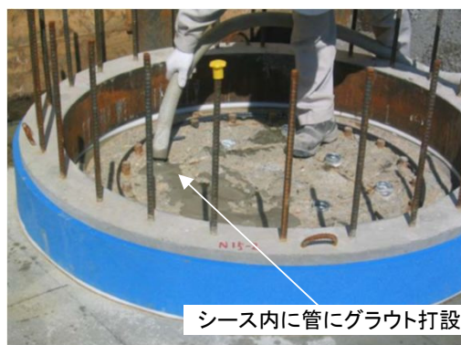
キャブテンパイル工法施工写真（HP）より抜粋
