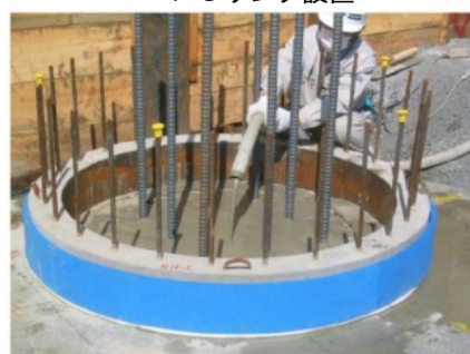
杭頭部モルタル打設、緩衝材設置
