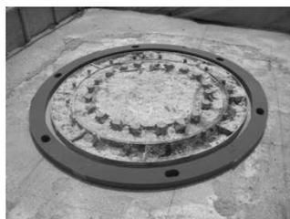
写真6 下端緩衝材組立完了
