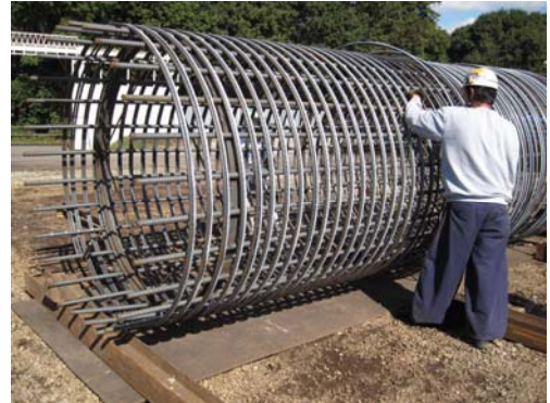
写真6 48巻き(450kg)配筋状況
