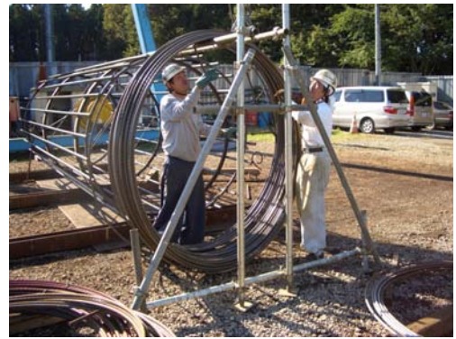
写真5 48巻き(450kg)架設状況
