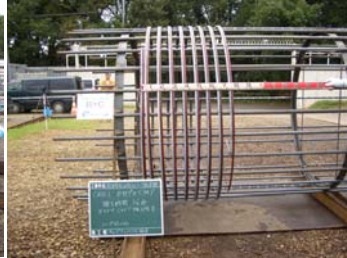
写真2 一般部配筋完了
