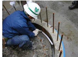
写真3 バックアップ材取付状況
