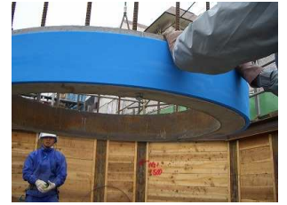
写真1 同左取付け状況
