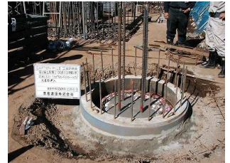
写真4 硬練りモルタル施工状況
