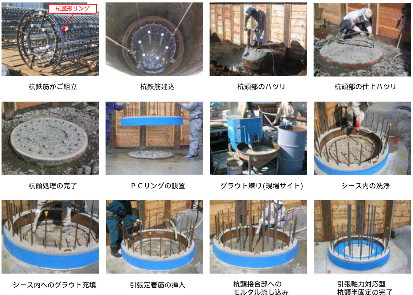
写真1 施工実験3における施工手順及び状況
